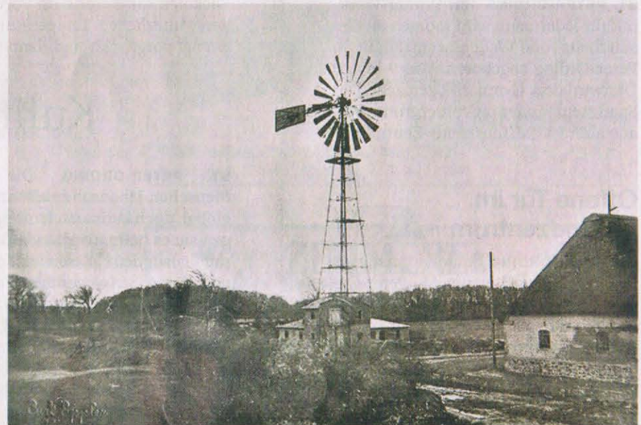
Die Herkulesmühle versorgte 1923 gut 120 Lampen und fünf Motoren mit je fünf PS zum Dreschen und Häckseln mit Strom.
