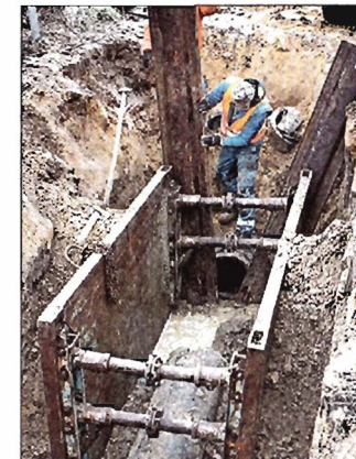
Nur kleine Baugruben waren nötig. Foto: WV Nord
