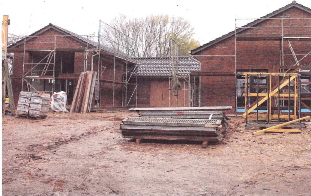
Das neue Feuerwehr- und Dorfgemeinschaftshaus nimmt inzwischen Formen an. FOTO: SCHLÜTER
