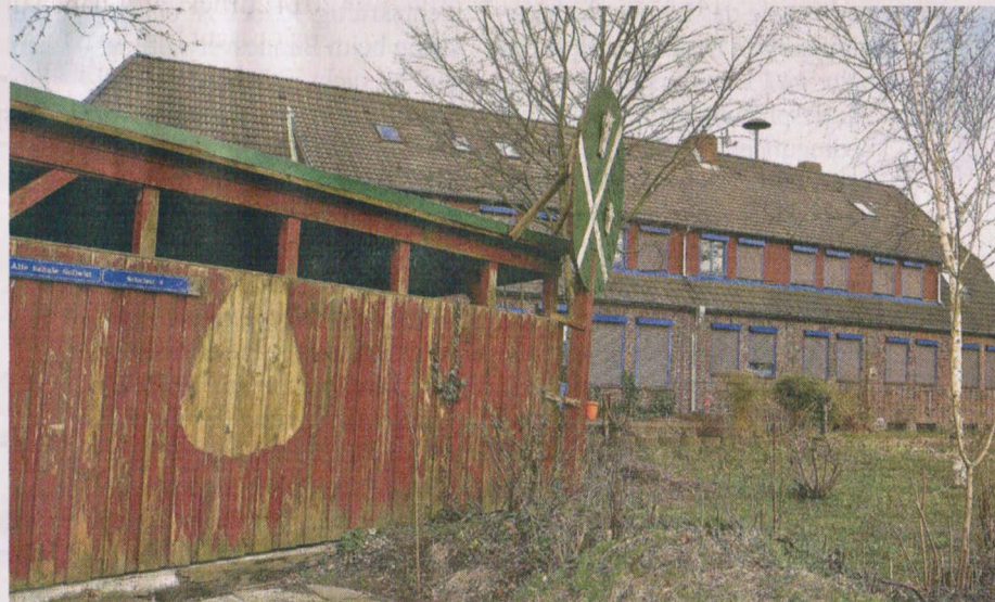
Die Alte Schule Sollwitt kommt als Gemeindezentrum nicht in Frage.
